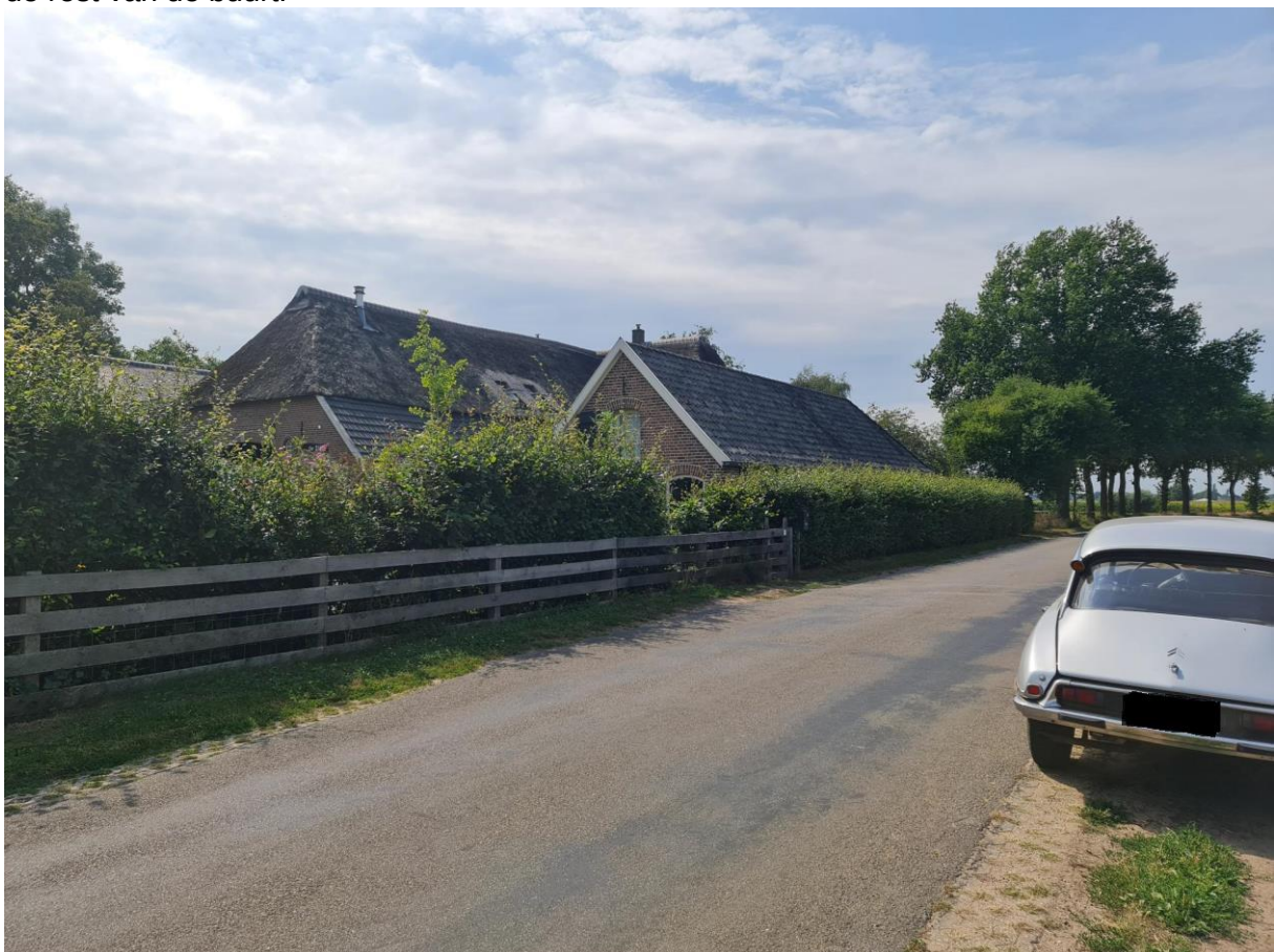
Figuur 3: Foto woning
