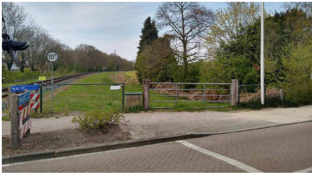
Spoorlijn met overgang aan de Almenseweg
